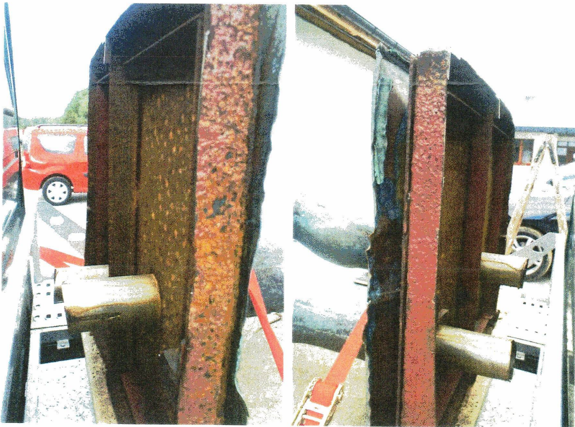
fot. 10, 11. Atlas ze zwieńczenia wieży M R w Siedlcach w trakcie przechowywania po demontażu. Pokazane fragmenty konstrukcji stabilizującej rzeźbę wykonane ze stali. Stan w dniu 21 września 2021 r.
