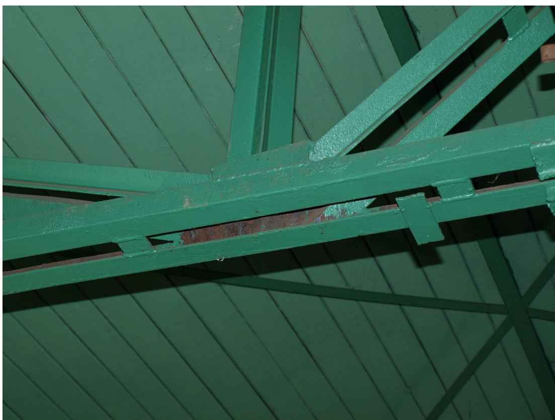
Fot. nr 7. Zawilgocone i zagrzybione deskowanie na zewnątrz budynku.
