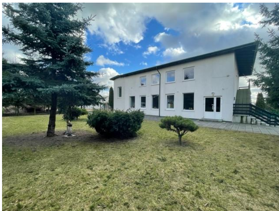
Fotografia 32. Widok przedszkola z zewnątrz
