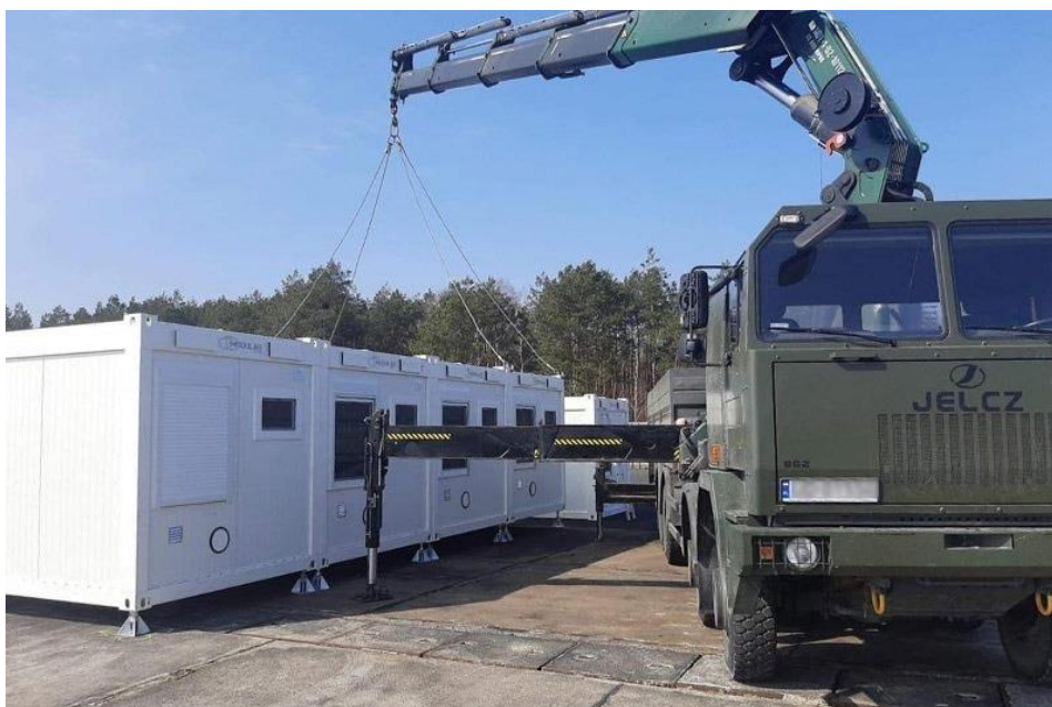
Fot. 18. Budowa tymczasowych koszar w Białej Podlaskiej
