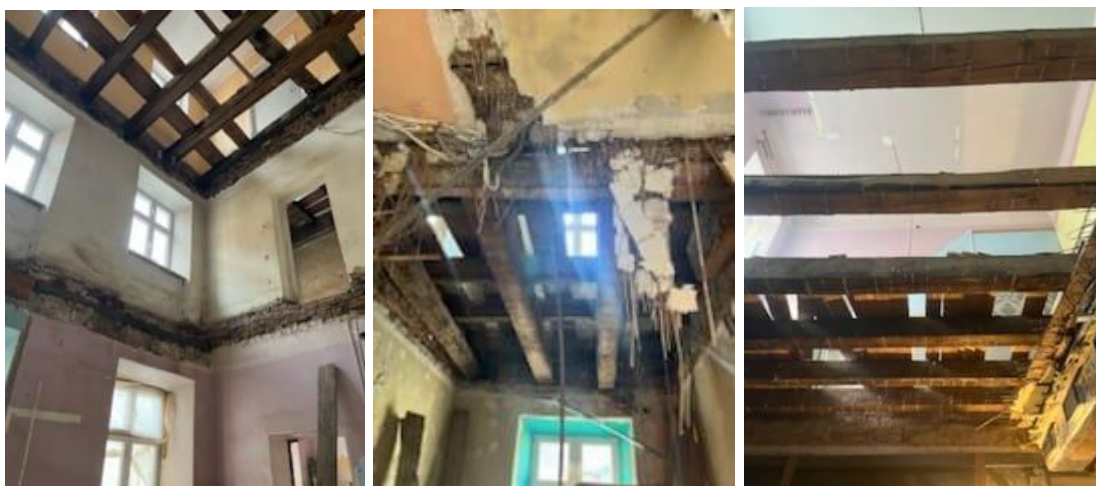
Rysunek 94. Osiemnastowieczny strop drewniany, który z racji konieczności podwyższenia klasy odporności ogniowej musiał zostać zdemonstrowany.
