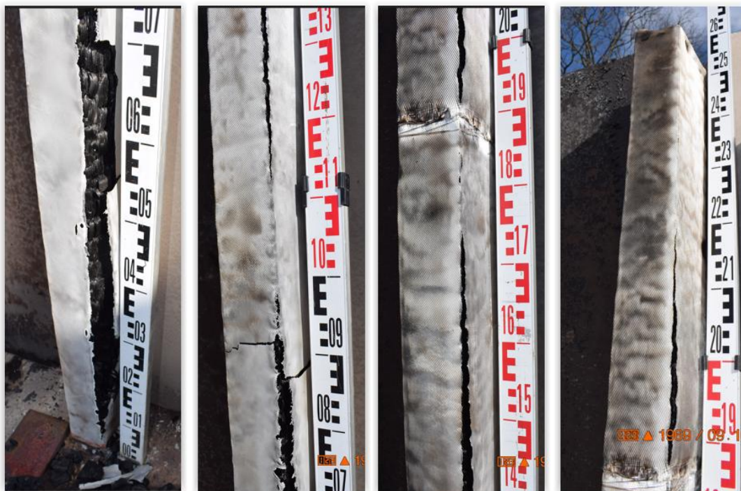
Rysunek 77. Uszkodzenia powłoki włókno szklane tzw. kocówka
