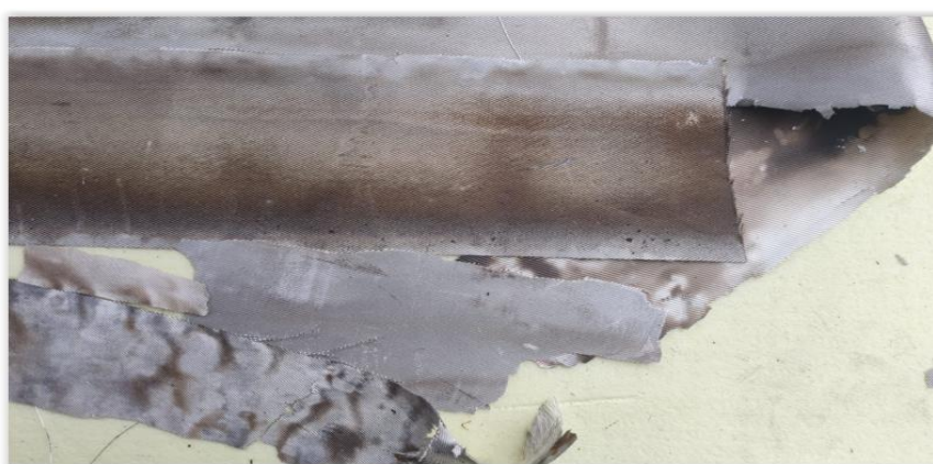
Rysunek 81. Pozostałości powłoki z modyfikacją aluminium po zdemontowaniu z zabezpieczonego elementu
