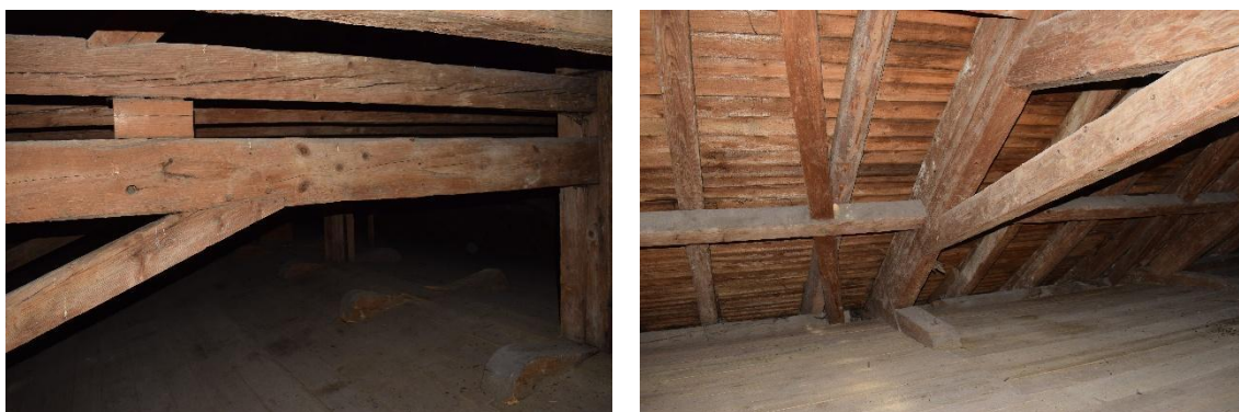
Rysunek 95. Zabezpieczane elementy więźby dachowej
