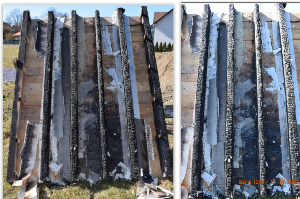
Rysunek 79. Stan ściany po demontażu osłon GKF
