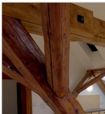
Rysunek 7. Elementy więźby dachowej zabezpieczone impregnatem, informacje z dokumentacji technicznej jednego z producentów systemów ogniochronnych 108
