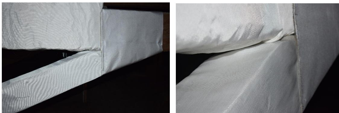
Rysunek 98. Wykorzystanie trzech kawałków materiału do dokładnego zabezpieczenia węzła konstrukcji drewnianej
