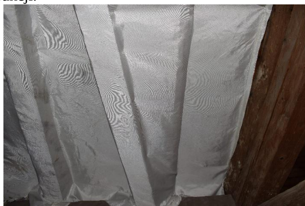
Rysunek 96. Zabezpieczone deskowanie oraz krokwie
