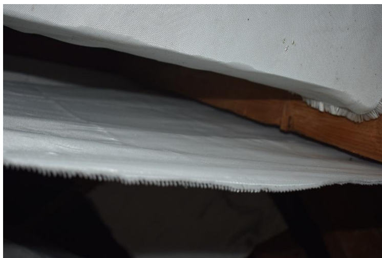
Rysunek 97. Tkanina szklana rozpięta na linkach stalowych. Pełne zabezpieczenie i deskowania oraz pozostałych elementów połaci dachowej w tym obszarze
