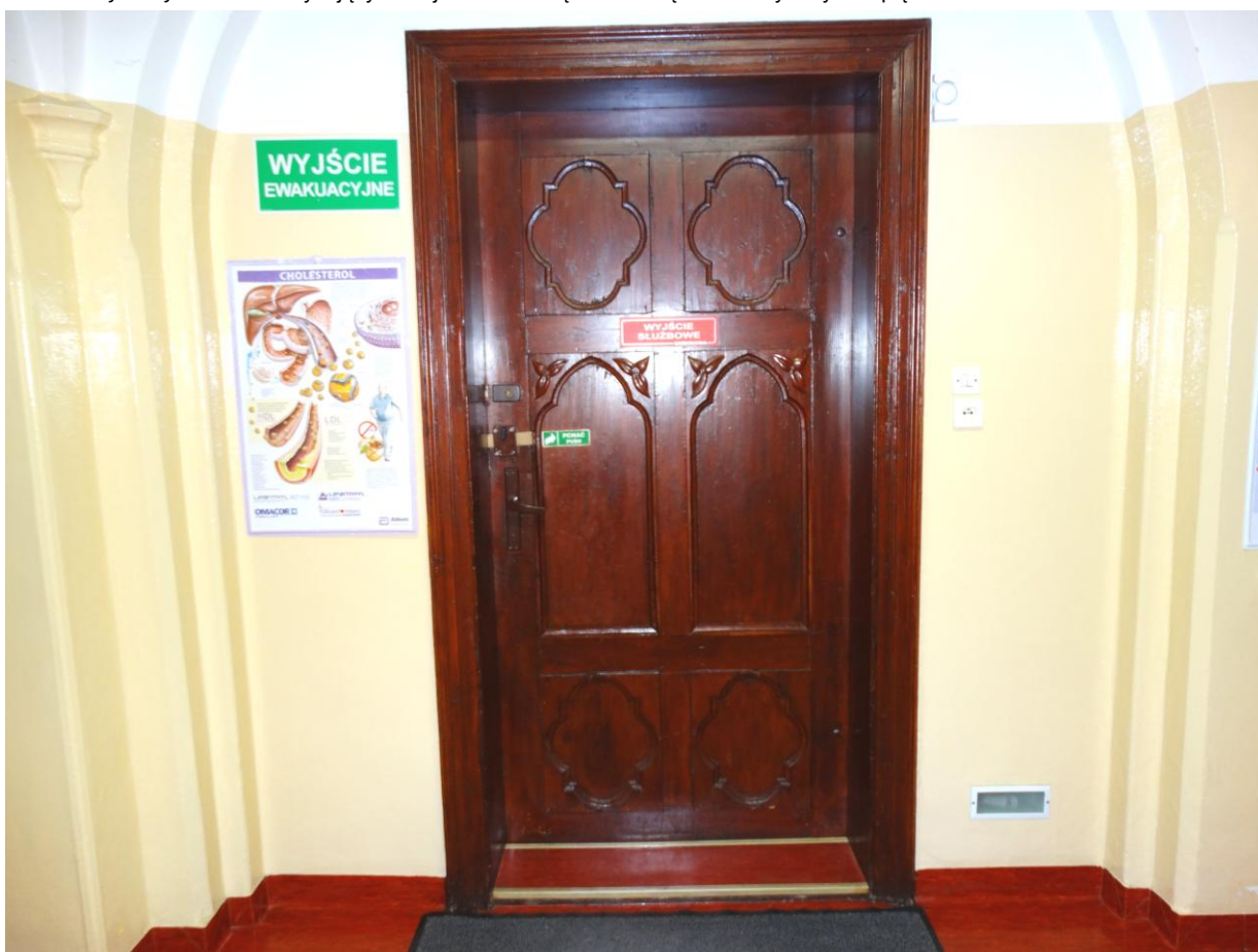
Widok zabytkowych drzwi zamykających wejście na klatkę schodową nr 1 z korytarzy I i II piętra
