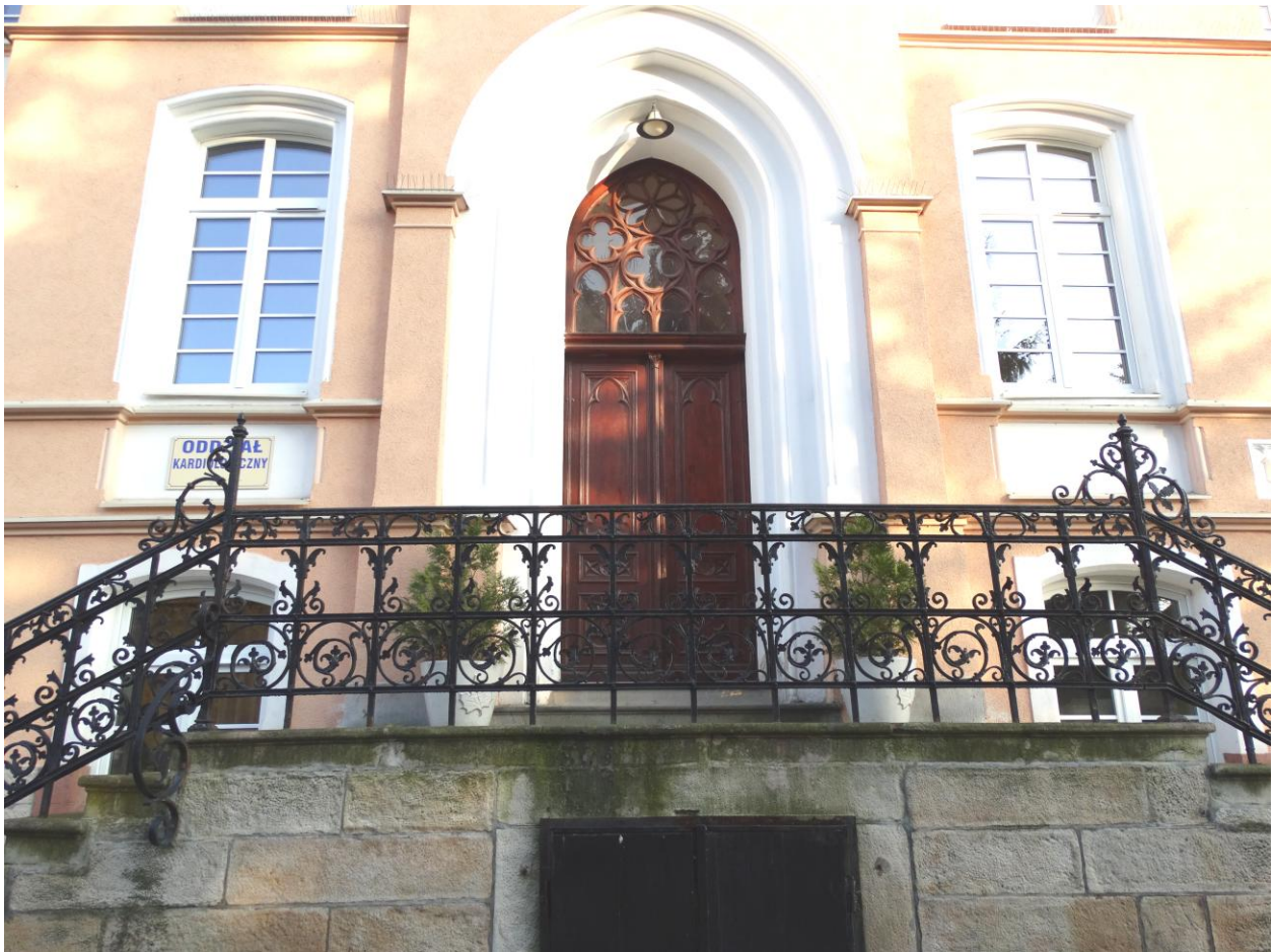
Widok zabytkowych drzwi wyjściowych z I piętra (z oddziału kardiologicznego)
