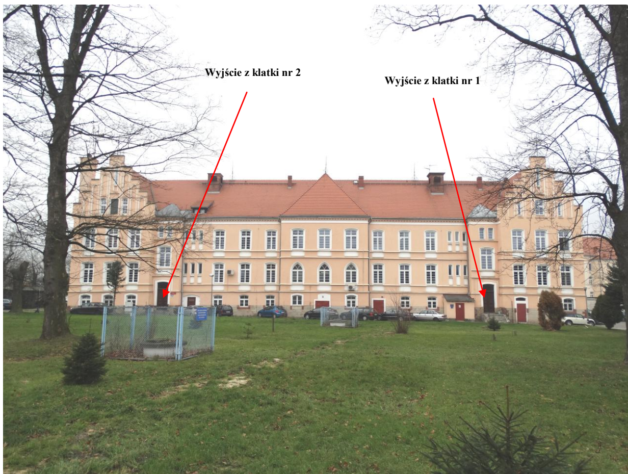
Widok budynku oddziałów wewnętrznego i kardiologicznego od tyłu
