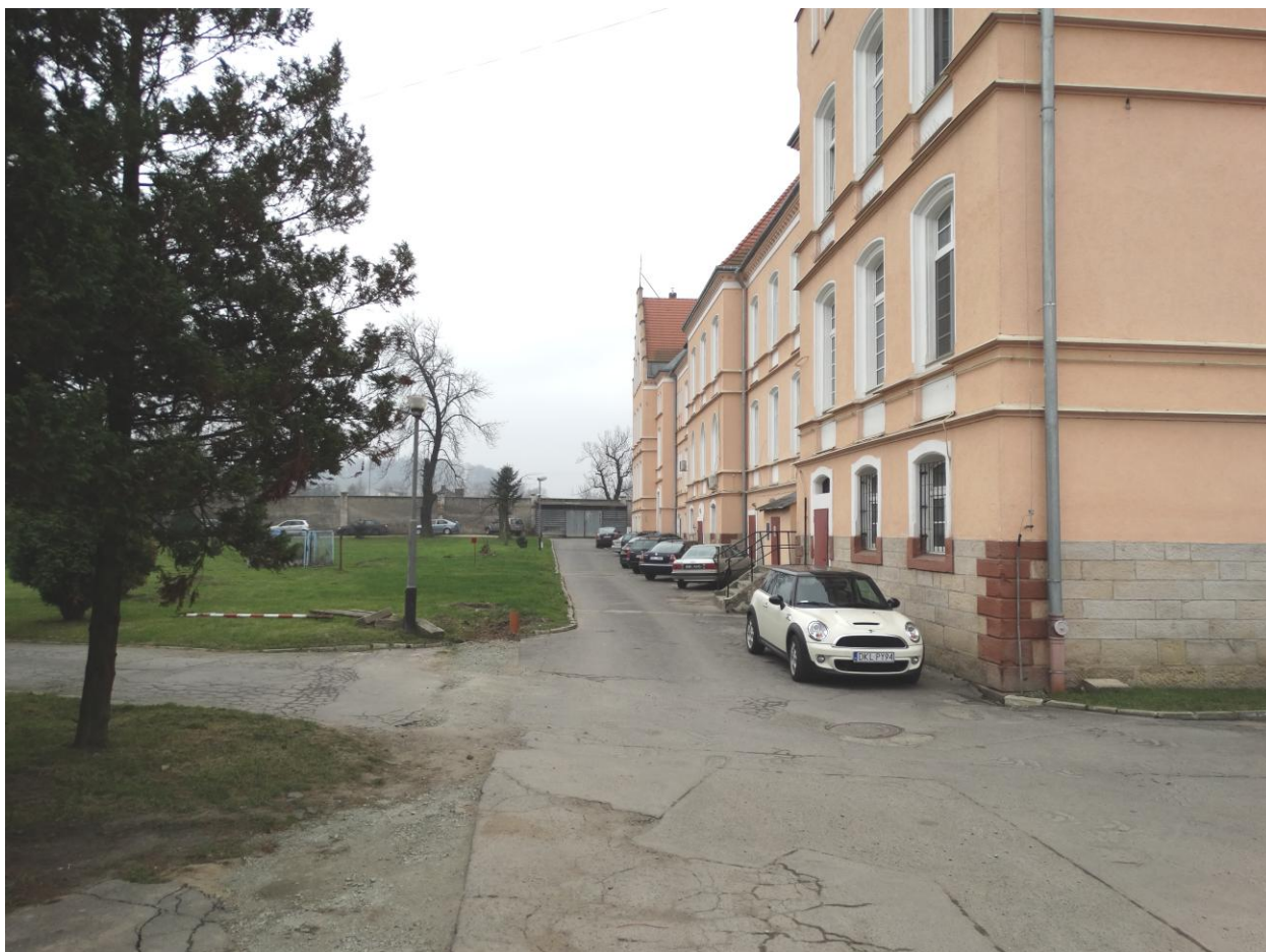
Widok drogi wzdłuż tyłu budynku (planowane jest wprowadzenie zakazu parkowania samochodów przy budynku)
