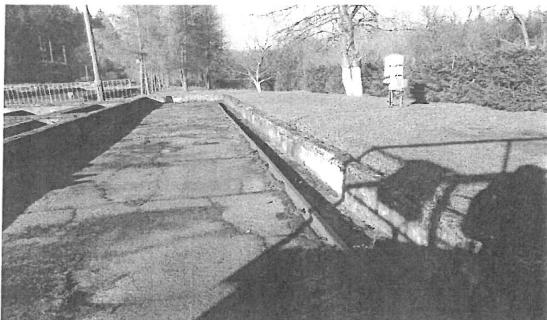
Fot.36 Torowisko wózka transportowego zgarniacza osadów. Widoczne spękania płyt betonowych wraz z ich zapadnięciami.
