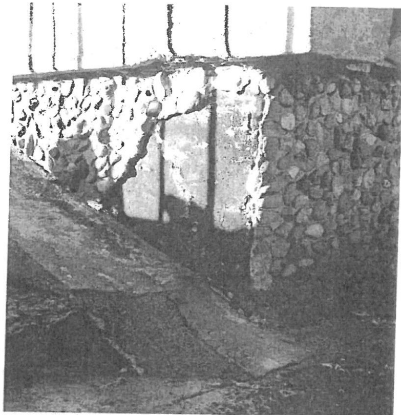
Fot. 7,8,9. Ściany budynku kratowni. Oblicówki wykonane z kamieni żwirowych, położone na izolacji przeciwwilgociowej ABIZOL.
