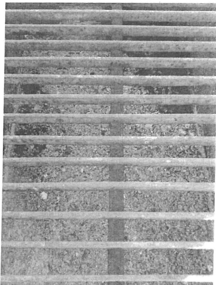
Fot.23,24. Widok ogólny na osadniki wstępne, zbliżenie tłuszczownika
