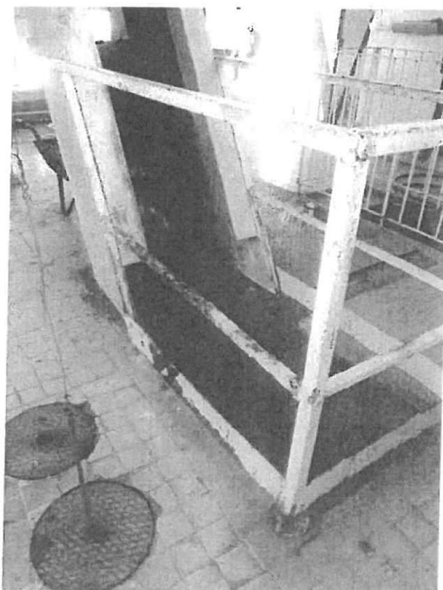
Fot. 12,13. Krata mechaniczna. Widoczne skorodowania elementów metalowych
