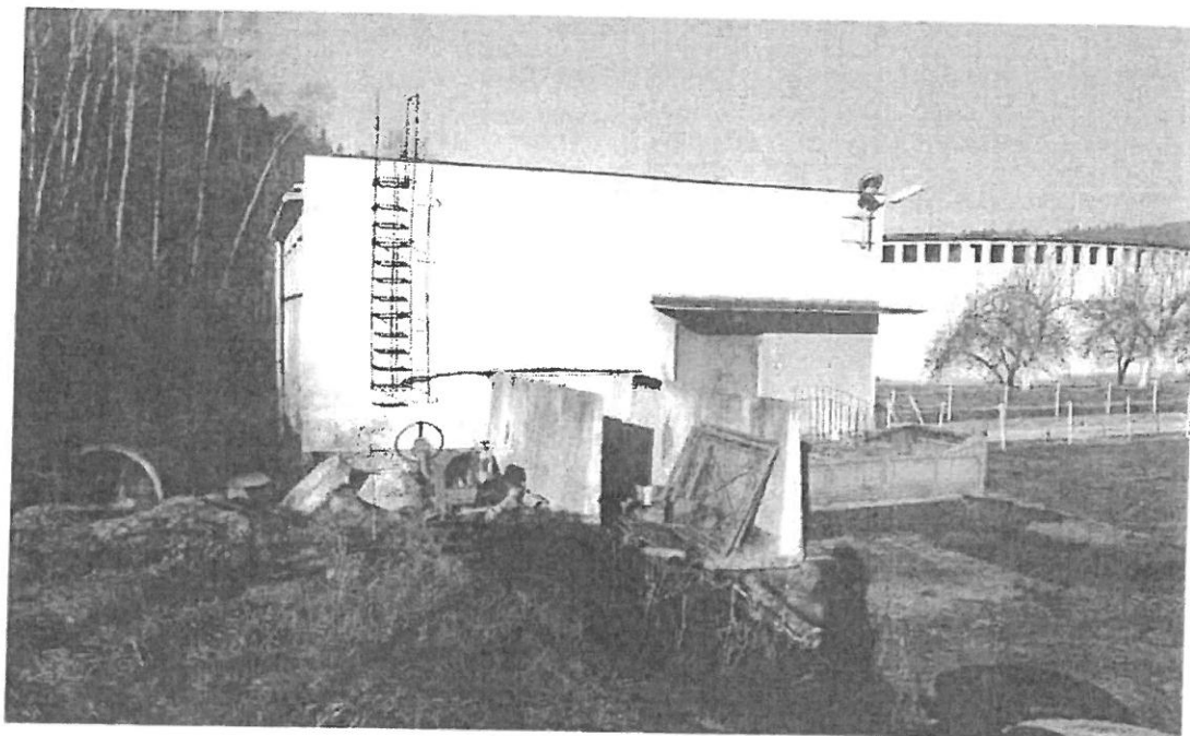
Fot.6. Widok ogólny na budynek krat od strony dopływu ścieków. Budynek murowany, stropodach żelbetowy, fundamenty i podmurówka betonowe.
