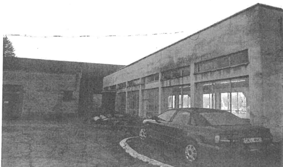
Fot. 38,39 Pompownia ścieków i osadów
