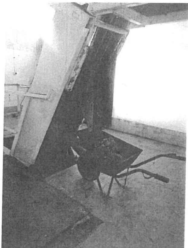
Fot. 12,13. Krata mechaniczna. Widoczne skorodowania elementów metalowych
