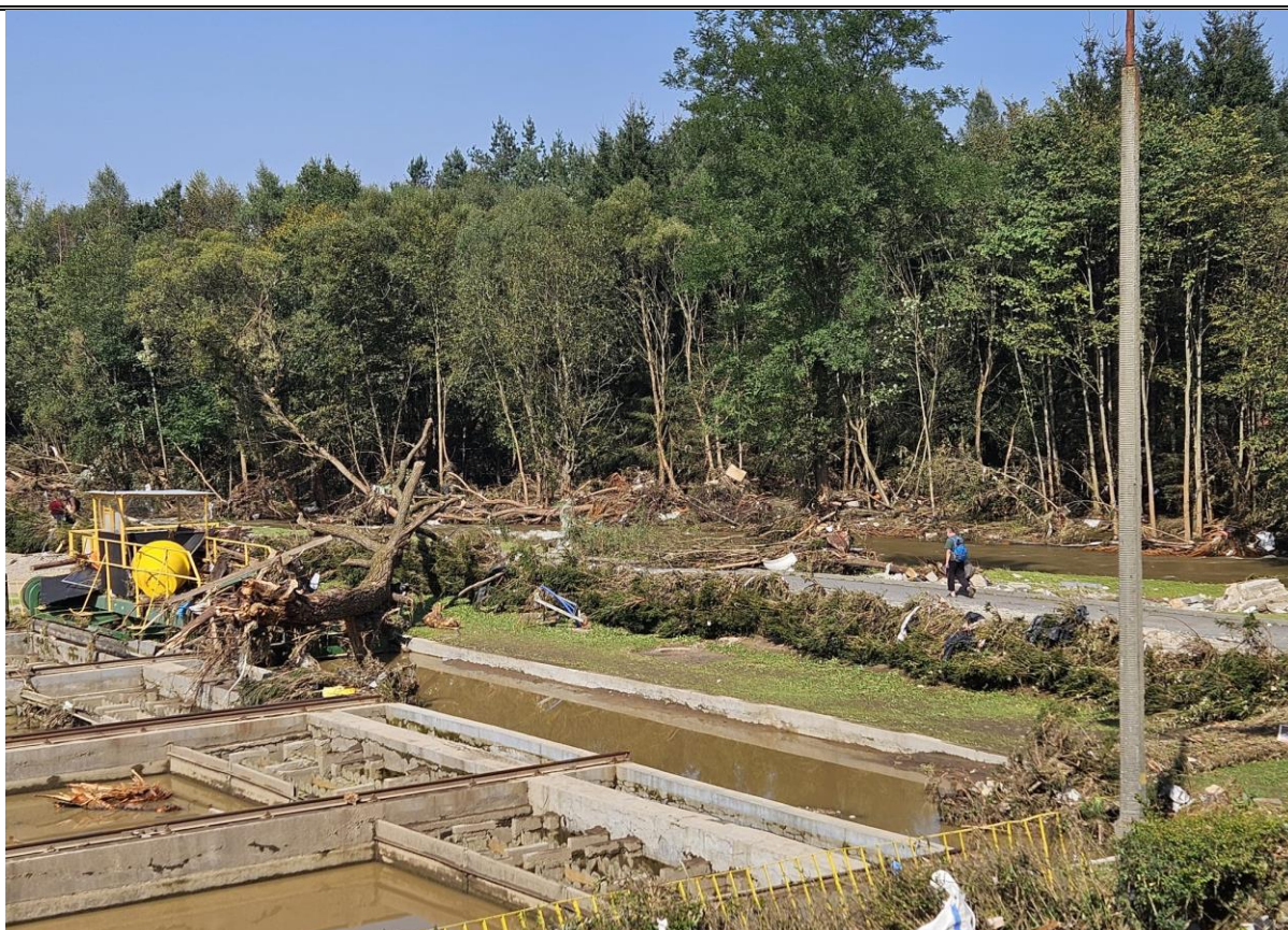
Fot. nr 4 – Oczyszczalnia ścieków w Łądku Zdroju osadniki wstępne i wtórne 2024.09.17 (dwa dni po fali powodziowej)
