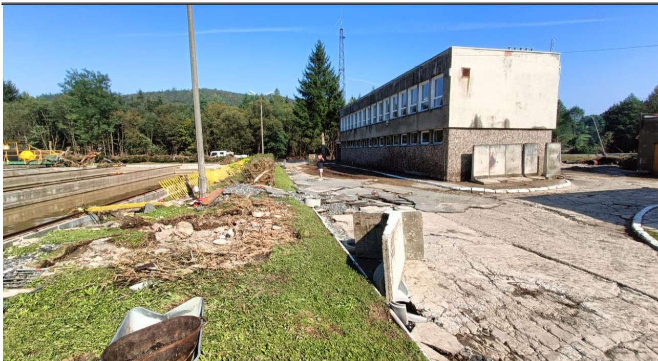
Fot. nr 1 – Oczyszczalnia ścieków w Łądku Zdroju 2024.09.17
