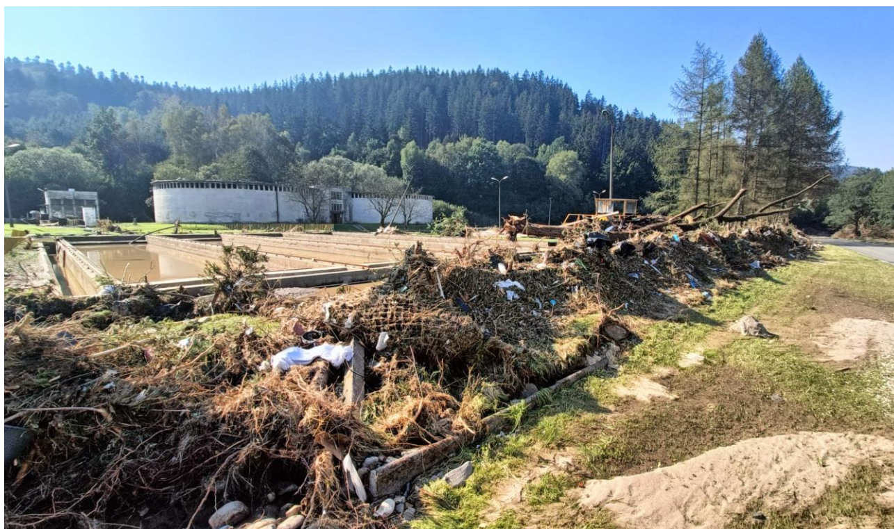
Fot. nr 2 – Oczyszczalnia ścieków w Łądku Zdroju 2024.09.23
