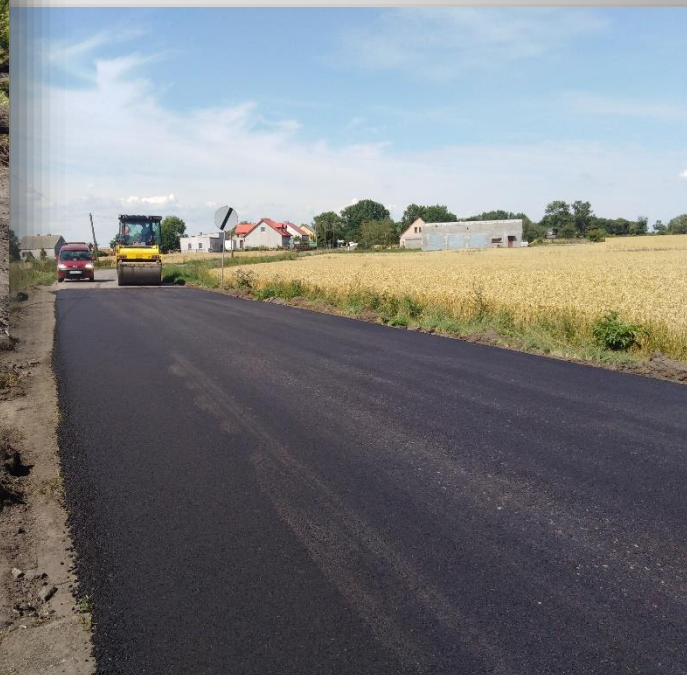
Droga powiatowa nr 2522C Ściborze – Mierogoniewice.
