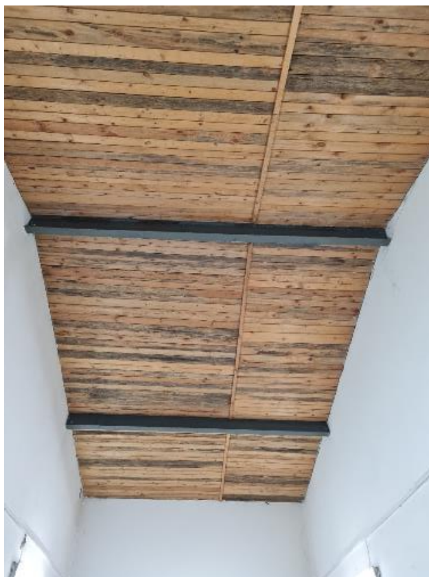
- Oparcie pŁatwi stalowej I 200 na podciŁgu stalowym I 300:
