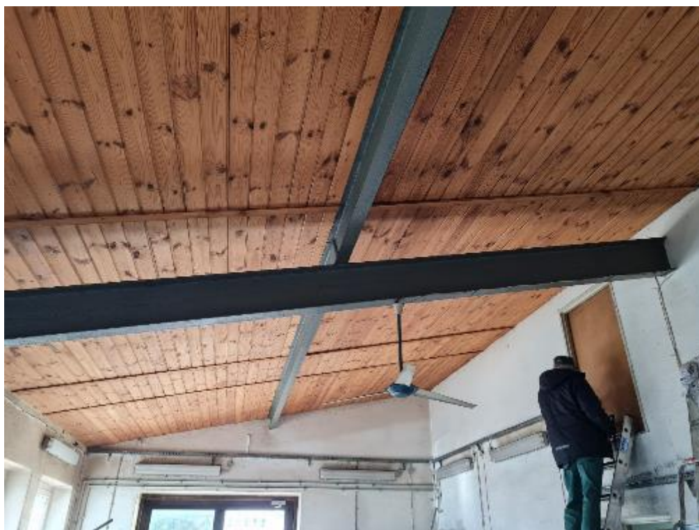
- Oparcie pŁatwi stalowej I 200 na podciŁgu stalowym I 300:
