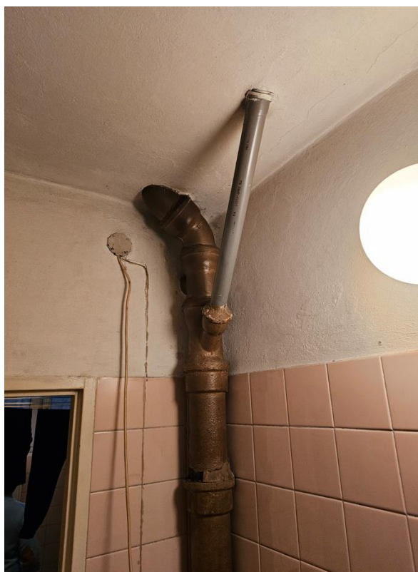
Zdjęcie nr 2, 3– istniejące piony kanalizacji (wszystkie do wymiany)
