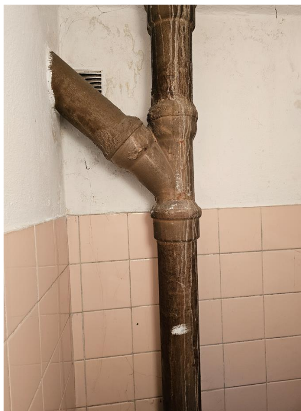
Zdjęcie nr 2, 3– istniejące piony kanalizacji (wszystkie do wymiany)
