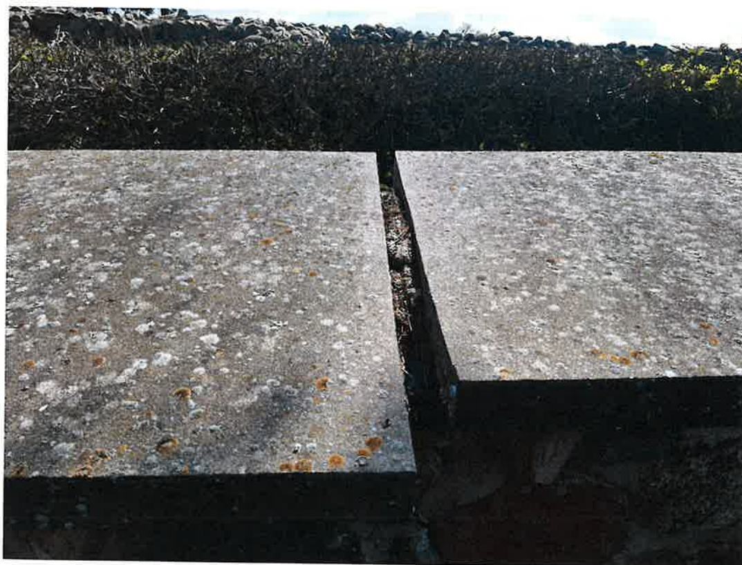
Zdjęcie nr 9 – mur ogrodzeniowy
