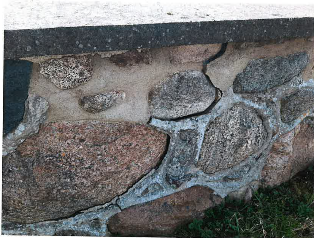
Zdjęcie nr 8 – mur ogrodzeniowy
