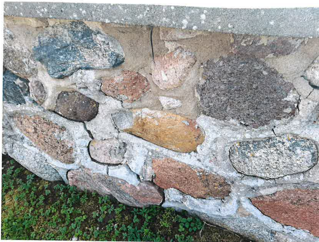
Zdjęcie nr 9 – mur ogrodzeniowy
