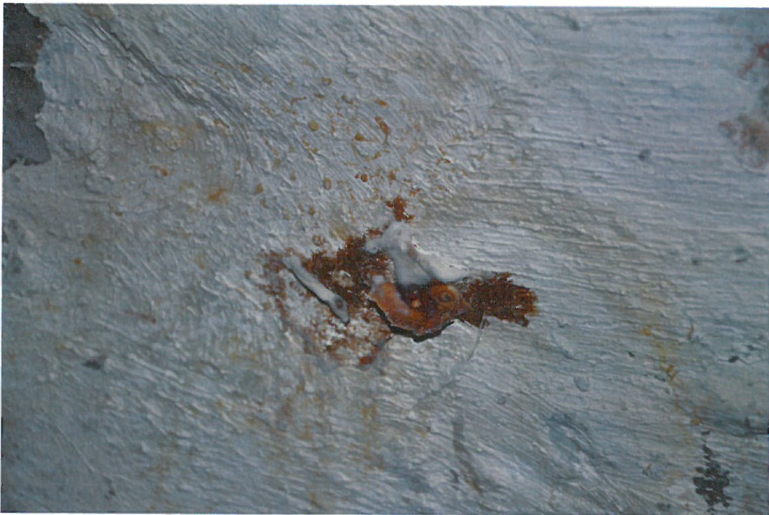
Fot.28. Przyschnięty owocnik grzyba z rodzaju Peziza sp. wyrastający ze ściany piwnicy
