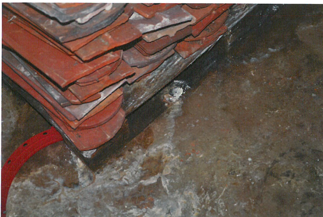
Fot.24. Zagrzybienie (rozkład brunatny) drewnianych przedmiotów znajdujących się w piwnicy. Widoczna grzybnia i sznury grzybniowe grzyba gnilicy mózgowatej
