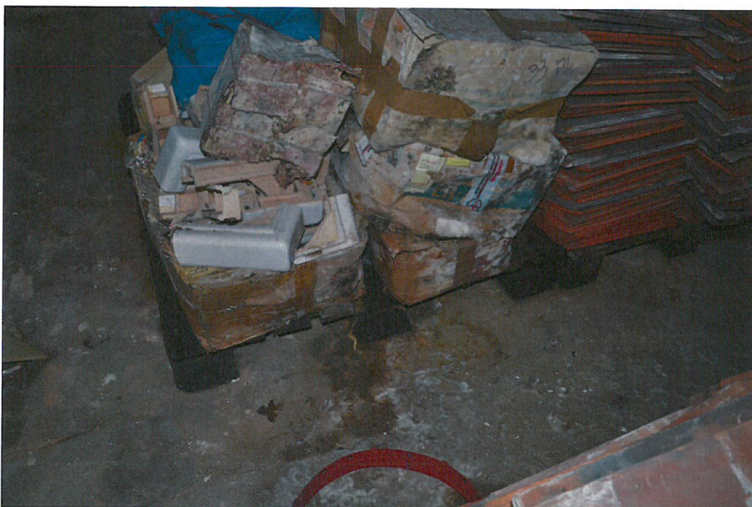
Fot.22. Zagrzybienie (rozkład brunatny) drewnianych przedmiotów znajdujących się w piwnicy. Widoczna grzybnia i sznury grzybniowe wyrastające z palety
