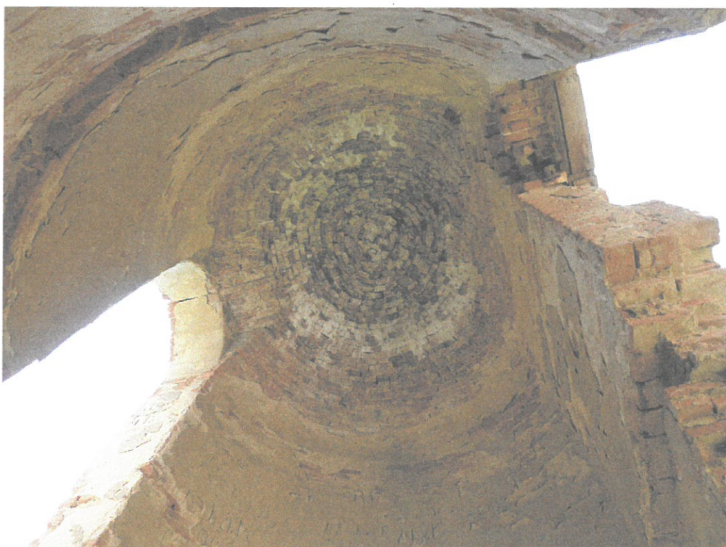
Fot. 8 Strop wieży.
