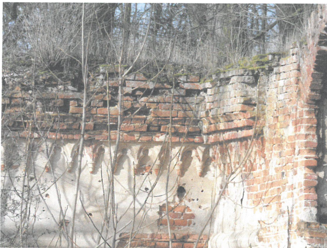
Fot. 5 Zbliżenie na fryz arkadkowy i pozostałości tynków.
